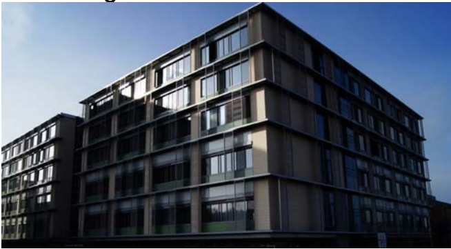
Abbildung: Das Krankenhaus St. Elisabeth in Ravensburg
